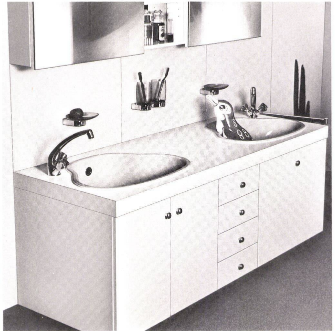
Doppelwaschtisch mit Unterbauten
