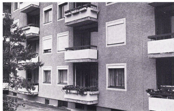
Kt. Zürich: Nachträglicher Einbau von ALUMBRINO-Rolläden
