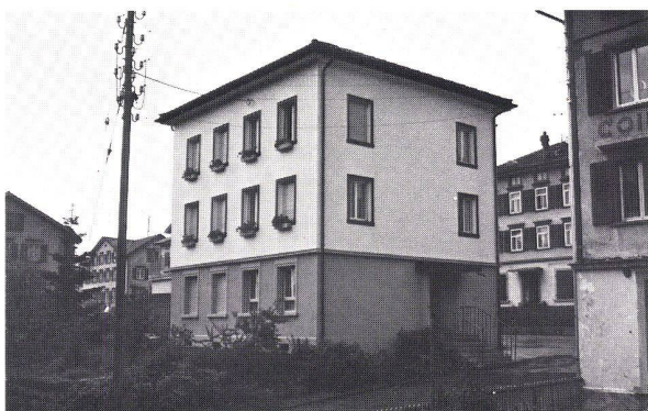
Kt. St. Gallen: Einbau von ALUMBRA-Rolläden
