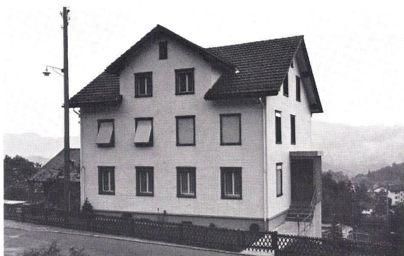
Kt. St. Gallen: Nachträglicher Einbau von ALUMBRA-Rolläden
