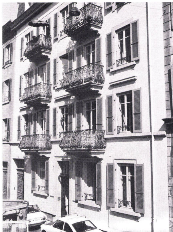
Kt. Neuenburg: Ersatz von alten JALOUSIELADEN durch neue
