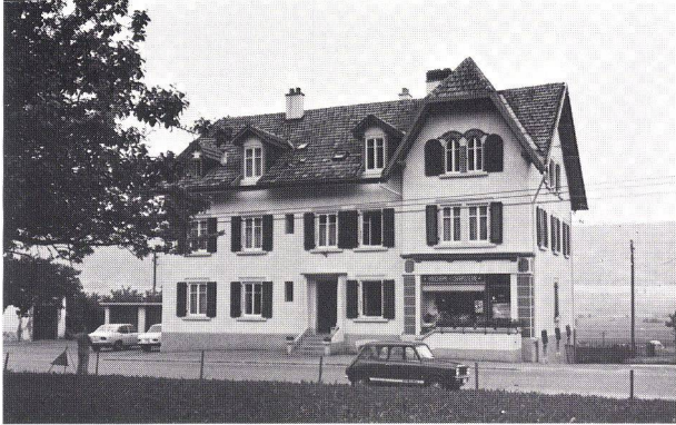
Kt. Neuenburg: Ersatz von alten JALOUSIELADEN durch neue
