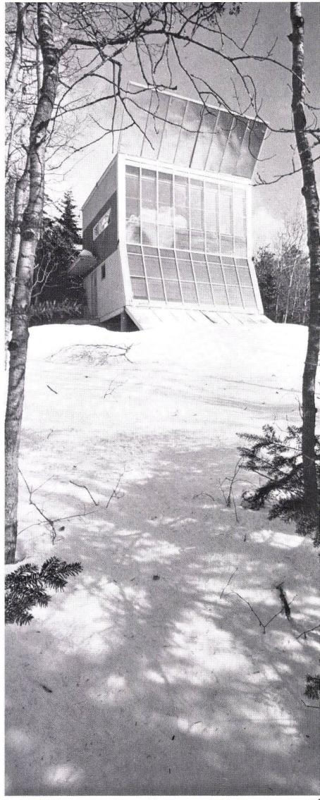
Die Skihütte wurde von den Architekten auf eigene Rechnung erstellt und erst nachträglich verkauft. Etwa 100 m<sup>2</sup> Wohnfläche werden von etwa 40 m<sup>2</sup> Kollektoren-, resp. Fensterfläche geheizt, die dank alu-beschichteter Reflektoren eine um das 1,5fache konzentrierte Sonnenbestrahlung erhalten.
