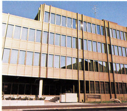
Siemens-Albis AG, Zürich, Schweiz, 1976 INFRASTOP-Auresin 39/28 Generalunternehmung Göhner AG, Zürich
