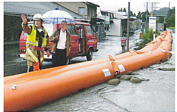
Um auf 1000 Metern den gleichen Schutz wie mit dem mobilen System zu erreichen, wären rund 75 000 Sandsäcke nötig.
