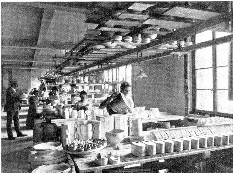
Porzellanfabrik Langenthal: Giesserei.
