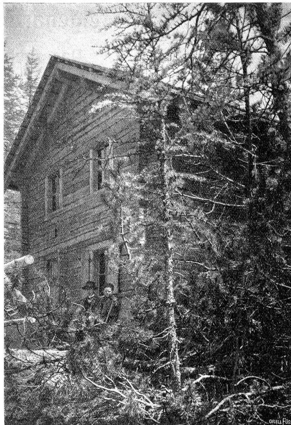
Blockhaus im Val Cluozza. Phot. Parkwächter Langen
