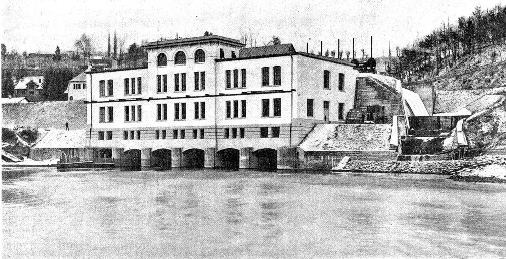
Das Elektrizitätswerk in der Felsenau bei Bern.
