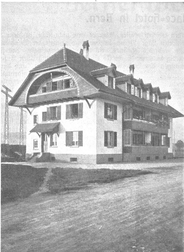
Elektrizitätswerk Kallnach. Maschinen-Wohnhaus.
