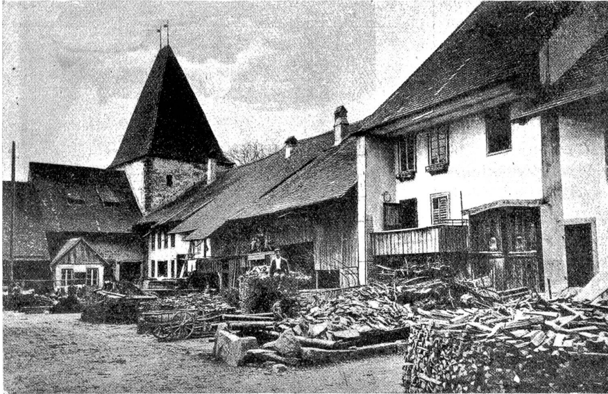
Die hintere Gasse in Wiedlisbach, in der die Kapelle steht.
