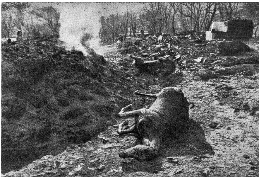
Aus einem von den Russen niedergebrannten Dorfe in der Bukowina.
