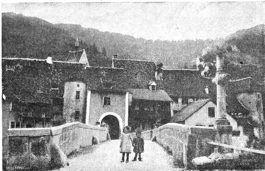
St. Ursanne. Brücke und porte du Clos du Doubs.
