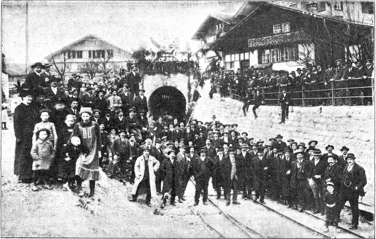
Das Westportal des Brienz-Dorf-Tunnels der Brienz-See-Seebahn am 4. Dezember 1914.
