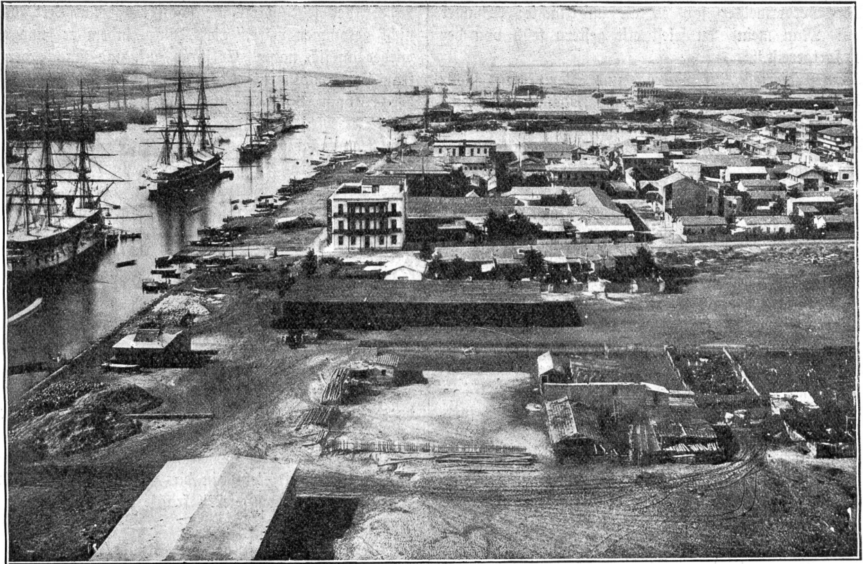
Port Said am Eingange des Suezkanals.
