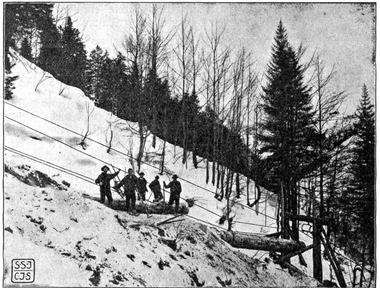
Eine sog. Seilriesen-Anlage. Mitteltst des Drahtseils werden die geschlagenen Holzstämme zu Tal gefördert.
