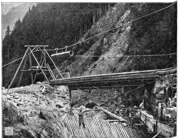
Das Drahtseil transportiert Röhren auf den Berg.
