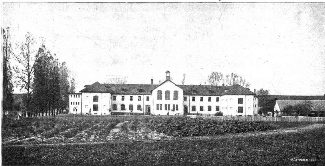
Das Gefangenengebäude (die Kaserne) in Witzwil.
