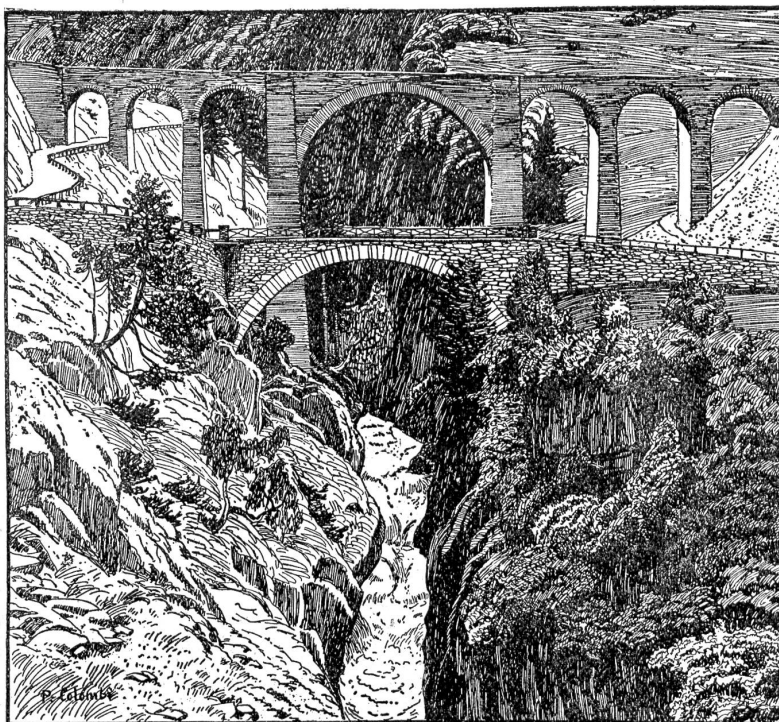
Viadukt und Strassenbrücke über die Rohneschlucht am Deischberg bei Grengiols.
