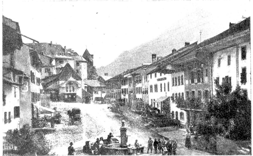
Die Strasse in Greyerz mit dem charakteristischen Abschluss durch die ehemalige Kapelle. Blick auf das Schloss und rechts auf den Dent de Broc.
