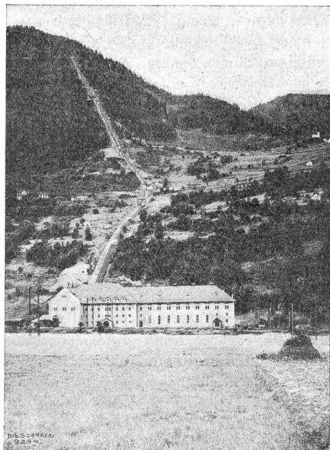
Zur Elektrifizierung der Gotthardbahn. Kraftwerk Ritom. Zentrale und Druckleitung.
