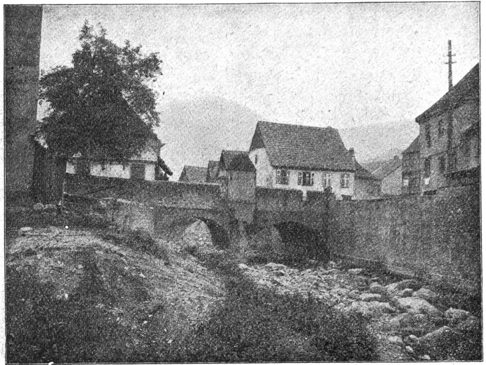
Befestigte Brücke der Weiss in Kaysersberg.
