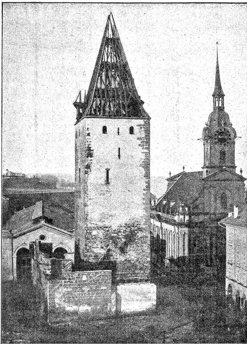
Der Christoffelturm im Abbruch. Beginn des Baues 1345 gleichzeitig mit der zweiten Stadterweiterung. In Kriegszeiten wurde auf dem Turm eine Hochwacht eingerichtet. (Zillier II. 288.) An ihn erinnert noch die Christoffelgasse. Er mußte nach dem Bau des heutigen Bahnhofes dem neuen Verkehr weichen und wurde 1864 abgebrochen. Er stand etwas unterhalb der Stelle, wo heute das Tramhäuschen steht.
