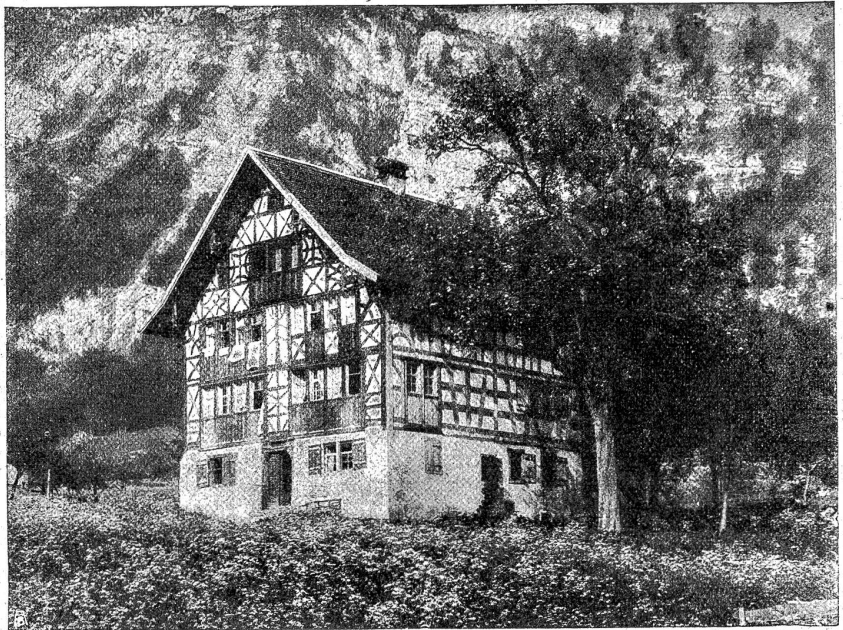
Fränkisches Haus. Fachwerk- und Riegelbau. (Netstal, Glarus.)
