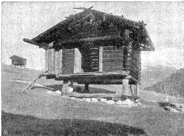
Kornspeicher auf Stelzen. (Graubünden und Wallis.)
