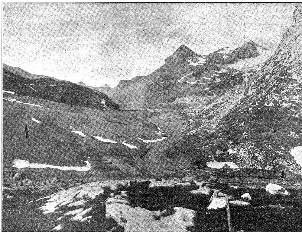
Das Kraftwerk Sanetsch. — Das Hochtal des Sanetsch. Das Stauseegebiet von unten gesehen. Oben die Paföhöhe.
