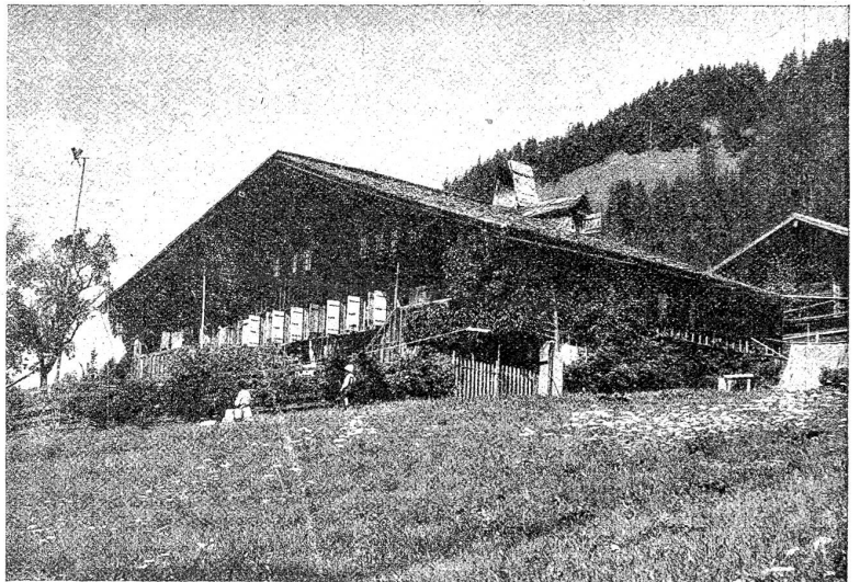
Alte Saanenhäuser. Auf dem Saali (erbaut 1708).
