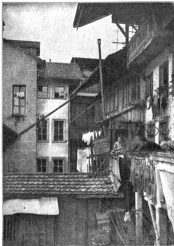
Ceilansicht von noch stehenden Häusern an der Matte, anschliessend an die abgebrochene Partie.
