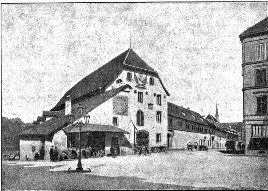
Das ehemalige Zeughaus in Bern (Ecke Zeughausgasse-Walphenhausplatz.)
