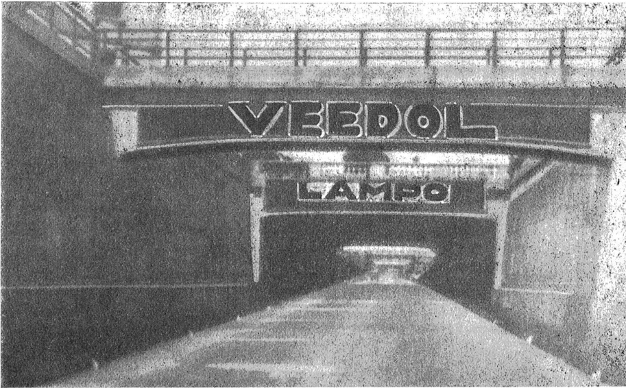
Ein typisches Beispiel bei einer Ortsunterführung bei der Ortschaft Olgiate auf der Strecke Mailand-Sefto-Calende.
