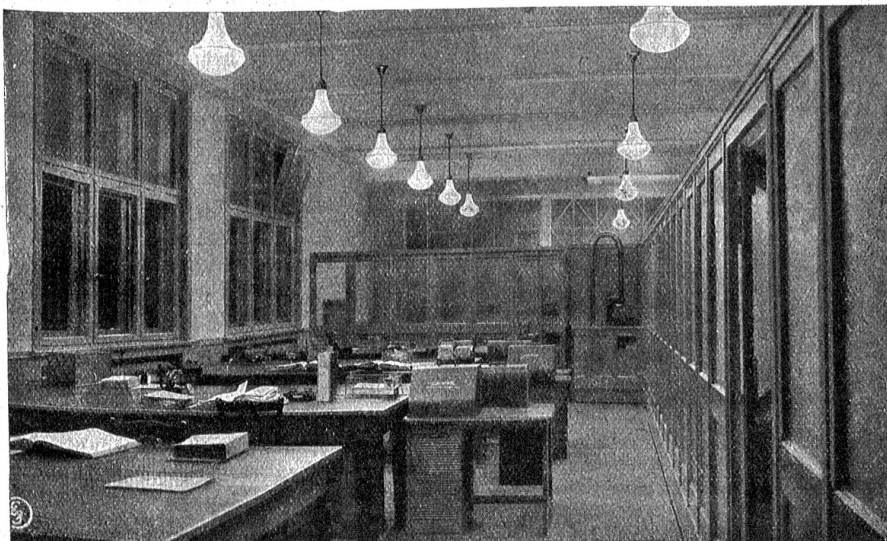
Bureau mit guter Allgemeinbeleuchtung, die jede Blendung ausschließt und den ganzen Raum gleichmäßig erhellt.
