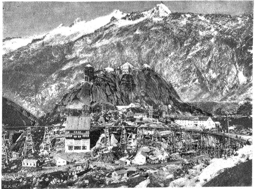
Blick auf Rollen von Westen, Zubringerbahn, Grobbrecherei und auf Rollen Betonieranlage und Unterkunftshäuser.
