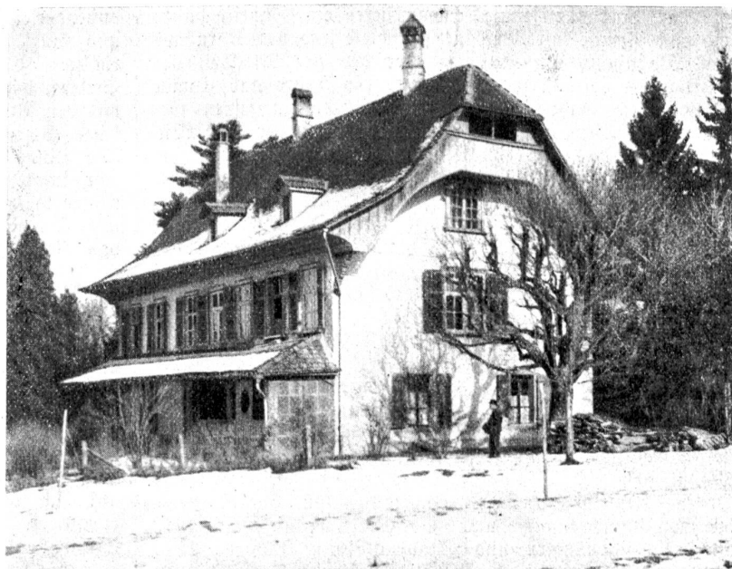
Das „Sprengerhaus“ in Großwabern.
