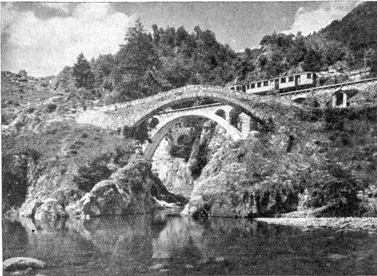
Abb. 1. Brücken im Centovalli, Tessin. Vorn eine alte Steinbrücke mit beidseitig ansteigender Fahrbahn; hinten die neue Eisenbahnbrücke mit Betongewölbe und Aufbauten mit Mauerwerkverkleidung.
