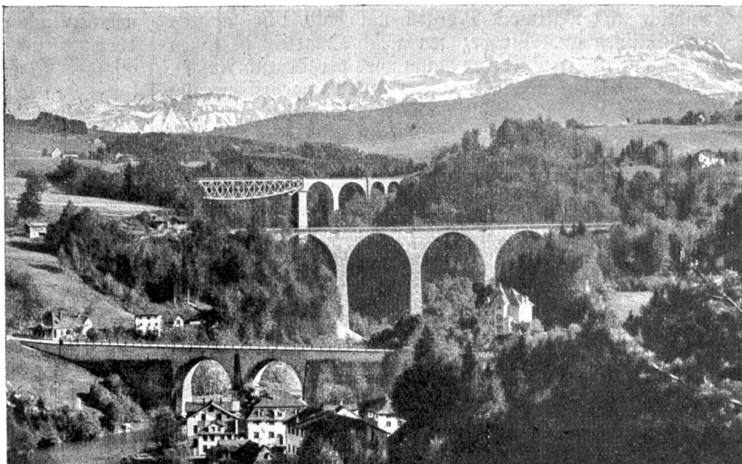
Abb. 7. Brücken über die Sitter bei Bruggen, Kanton St. Gallen. Die drei Brücken sind ein Wahrzeichen der Landschaft und ein schönes Denkmal moderner Technik.
