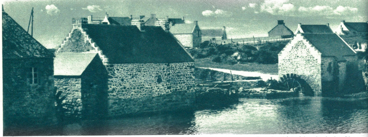
Aus der malerischen Bretagne: Alte Mühle bei Ekel in der Landschaft Morbihan. Der Antrieb erfolgt durch das Meer, wenn es sich bei der Ebbe zurückzieht. Die schlichten Gebäude verraten in aller Einfachheit einen sympathischen Stil.
