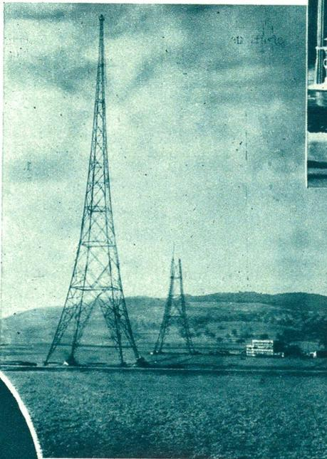
Links: Der neue schweizerische Landessender bei Sursee. Der eine der 125 Meter hohen Antennentürme ist bereits fertig, der zweite bis zur Hälfte erstellt. Man sieht auch den Neubau des Sendegebäudes.
