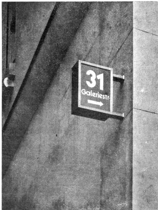
Hausnummer am Postamt Galeriestrasse in München. Duranametall und transparentes Ueberfangglas mit weiss ausgeblasener Schrift.
