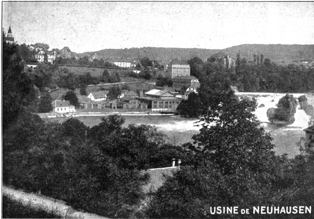
Aluminiumfabrik in Neuhausen am Rheinflall. (Errichtet 1888.)
