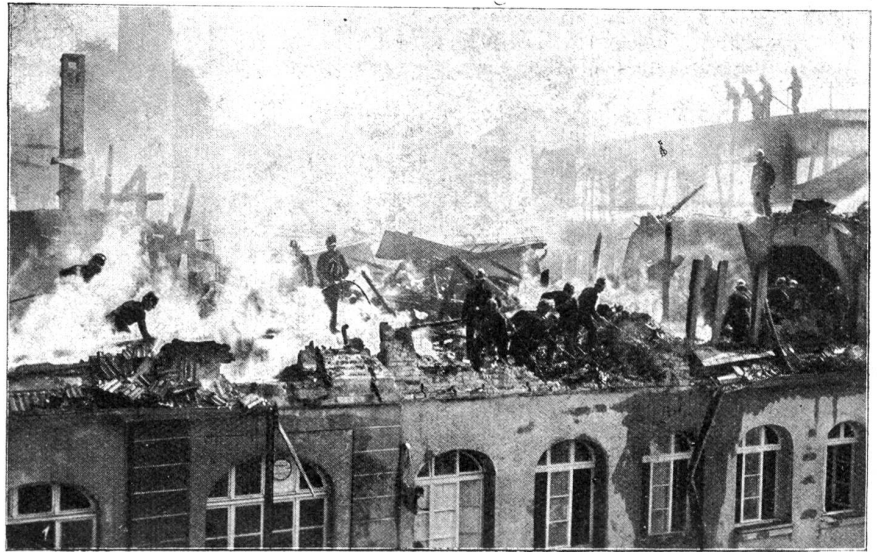
Der Brand der Wanderschen Fabrik- und Verwaltungsgebäude in Bern (29. Mai 1931). Phot. O. Rohr, Bern.
