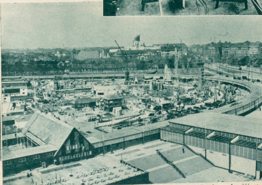
Übersicht über die Berliner Bau-Ausstellung, die inzwischen vollendet und eröffnet worden ist. Phot. Wide World, Berlin.
