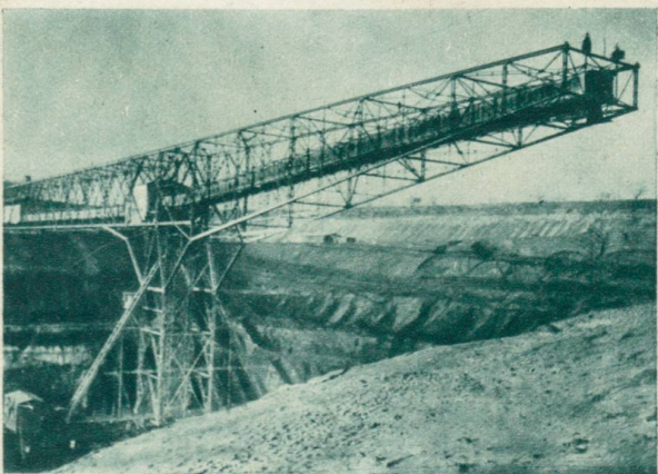
Die größte Abraumförderbrücke der Welt ist kürzlich in dem Braunkohlenrevier der Sächsischen Werke in der Nähe von Leipzig aufgestellt worden. Photo Löhlich, Leipzig.
