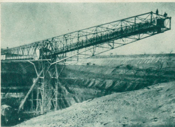
Die größte Abraumförderbrücke der Welt ist kürzlich in dem Braunkohlenrevier der Sächsischen Werke in der Nähe von Leipzig aufgestellt worden. Photo Löhlich, Leipzig.
