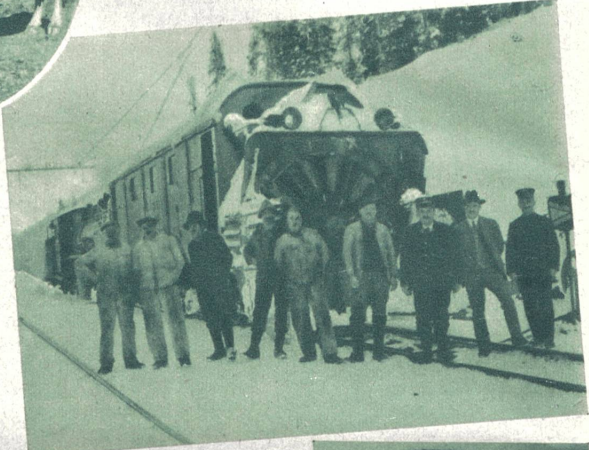
Die Schneeschleudermaschine der Rhätischen Bahn (im Bilde links) in voller Aktion auf Station Laret bei Davos. Die Schleudermaschine in der Nähe, mit Bedienungsmannschaft. Phot. A. Wegmann, Ragaz.
