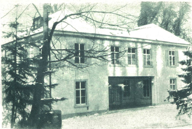
Das Parkhaus St. Margarethen in Basel, welches das neue Studio des Radio Basel beherbergt. Phot. A. Diriwächter.
