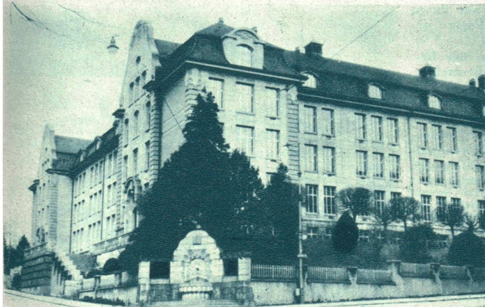
Das Kantonsschulgebäude mit der neusprachlichen Abteilung (Industrie- und Handelsabteilung).
