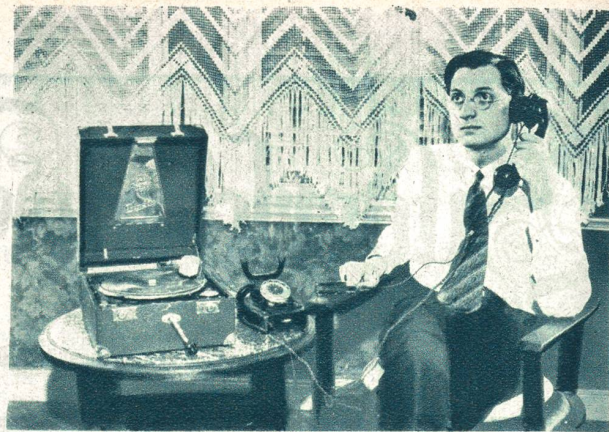
Das Telefongespräch auf der Schallplatte. H. Dillge, Mitarbeiter des Erfinders mit dem neuerfundene »Teleskriptor«, der jedes Telefongespräch, Rede und Gegenrede, mittels eines Verstärkers und einer Aufnahmevorrichtung auf kleine unzerbrechliche Schallplatten festhält. Man legt den »Teleskriptor« mittels eines Bügels über den Kopf und hält den Telephonhörer statt an das Ohr an die Muschel des Geräts. Photo Wide World, Berlin.
