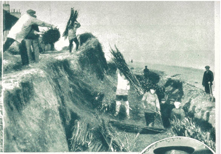
England beginnt sich gegen die Feindschaft der Seestürme zu schützen. Die englische Provinz Suffolk hat ihre Leuchttürme und Rettungsmannschaften an der Küste angewiesen, eine neue Art von Schutzdämmen zu bauen, die das unter der furchtbaren Wucht der Seestürme liegende Land vor den
