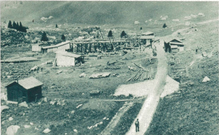
Vom Bau der Sântisbahn: Blick auf den heutigen Stand der Bauarbeiten auf der Schwägalp. In der Mitte das Gerüst der Schwebbahn für den Materialtransport von der Schwägalp auf den Sântisgipfel. Eine moderne Verkehrsstrasse ins Tal hinter ist ebenfalls im Bau.
