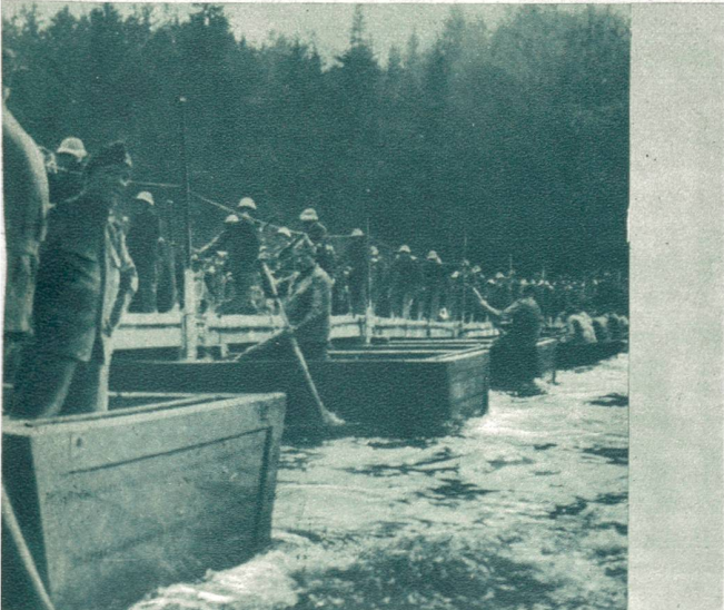
Die Pontonierbrücke über die Aare bei Talgut an den Manövern der 3. Division
