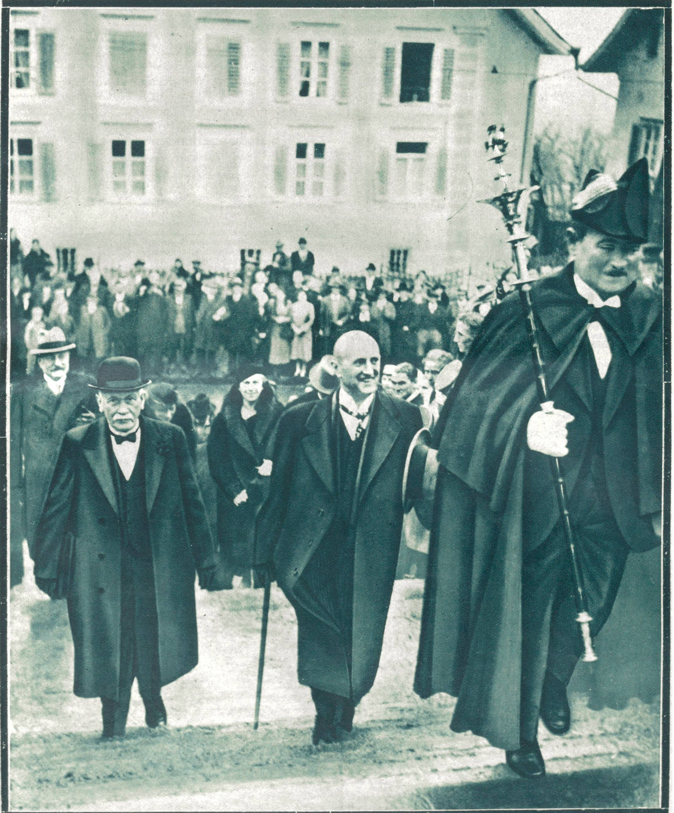
Grundsteinlegung für das Bundesarchiv in Schwyz
