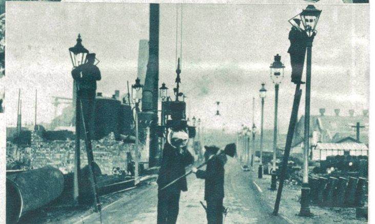
Englische Propaganda der Tat: Auf dem Weg zum Londoner Gaswerk Wendsworth steht alle paar Meter eine Gaslampe, während in grösseren Zwischenräumen auch noch über der Mitte des Weges Lampen hängen. Jede Lampe ist von verschiedener Machart und bildet diese Strasse so die beste Reklame für das Gaswerk und die verschiedenen Gaslampen-Hersteller. Unsere Aufnahme zeigt, wie Arbeiter des Gaswerks die Lampen putzen. Und doch — grosse Weltstadt London frage einmal einen Schweizerbuben, ob er deine alten Gasstrümpfe überhaupt noch kennt — es sei denn aus dem Unterricht über Kulturgeschichte! (Phot. Graphic Press Ltd.)
