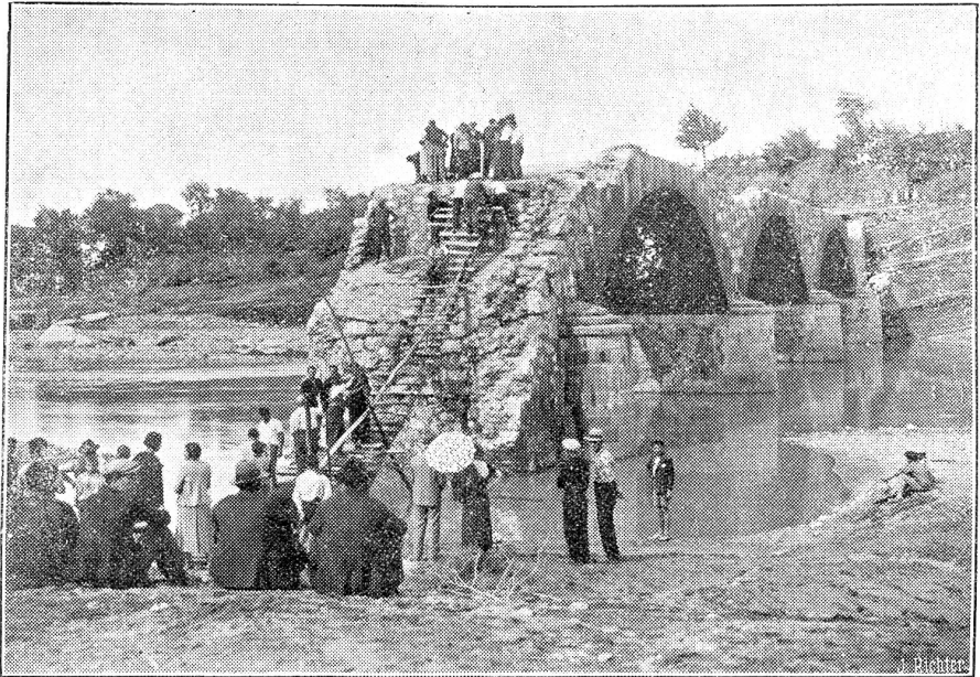
Der Dambruch bei Ovada (Italien). Unser Bild zeigt eine der vier eingestürzten Brücken.
