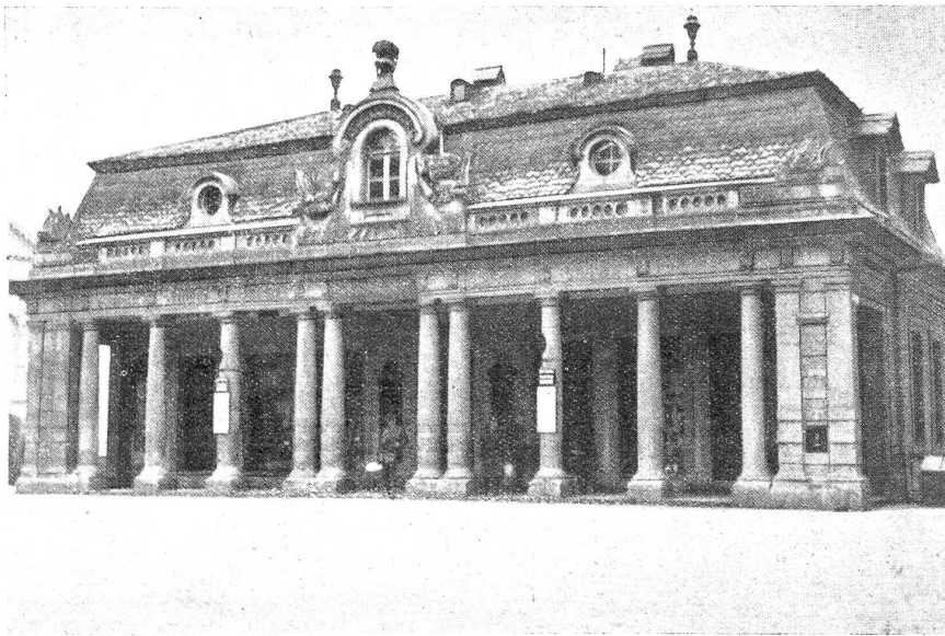
Die Hauptwache, heutiger Zustand. Die Fassade ist vernachlässigt und durch Tafeln beeinträchtigt. (Phot. E. Keller, Bern)
